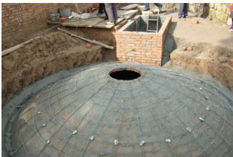
BMD／コンクリートで補強
